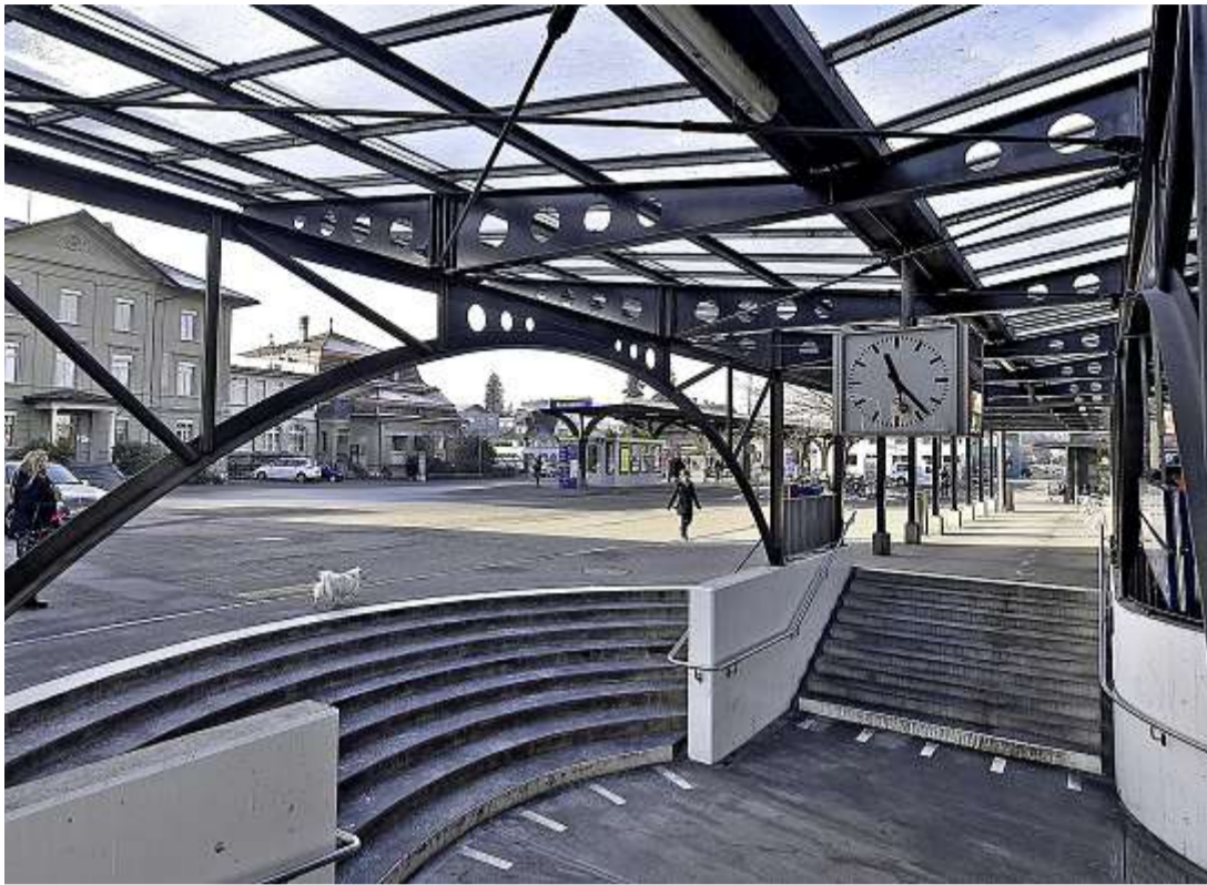
Gegenwart: Das Perrondach des alten RM-Bahnhofs (im Hintergrund) dient den Buspassagieren als Schutz vor Schnee und Regen. Die Holzkonstruktion ist noch nicht baufällig, soll aber abgebrochen werden.
